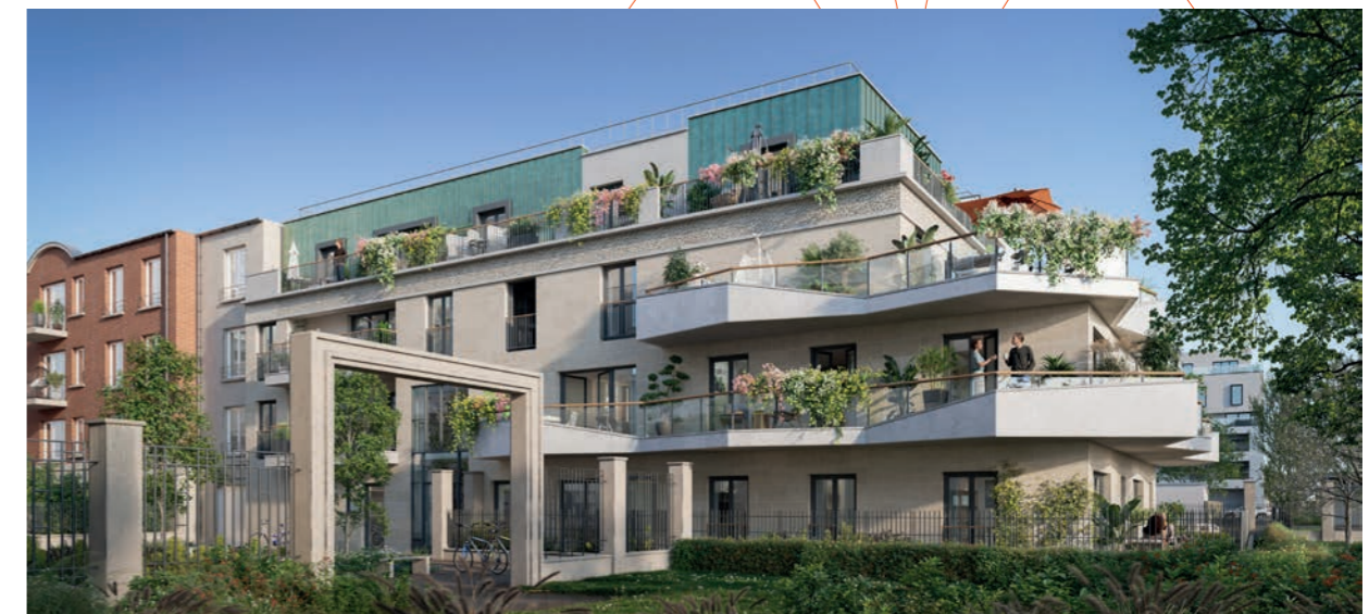
Vue de la façade du bâtiment D
