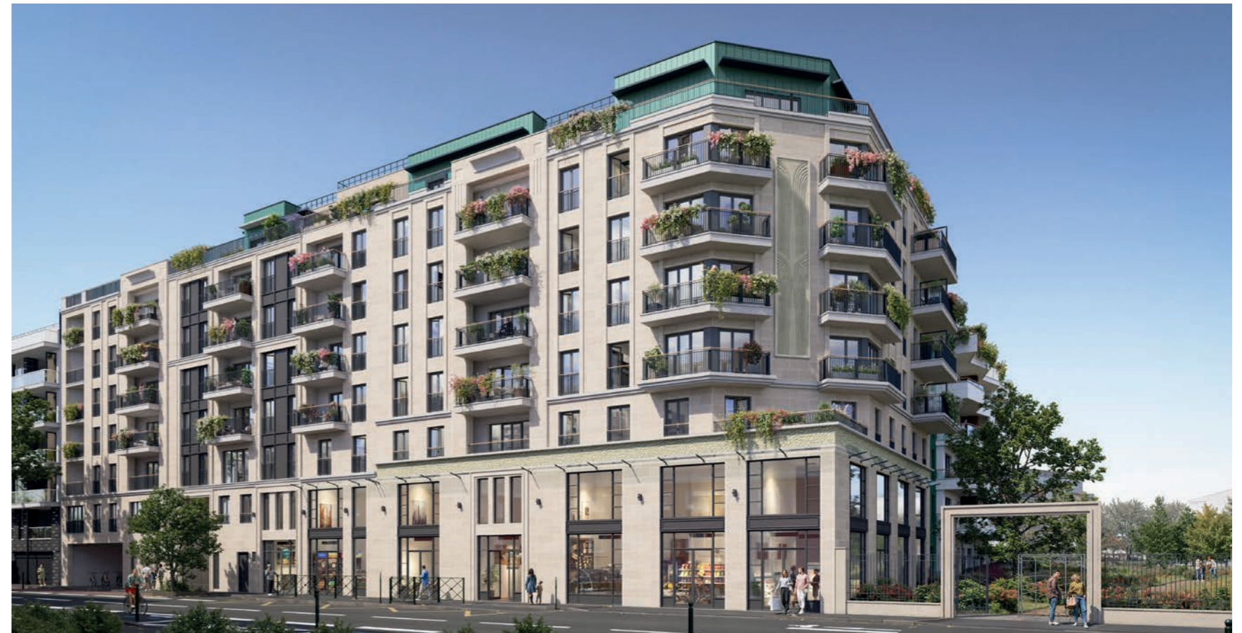
Vue de la façade côté Boulevard Voltaire / Entrée du parc
