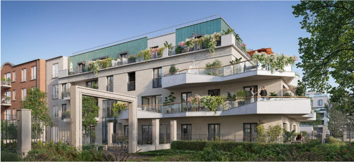
Vue de la façade du bâtiment D
